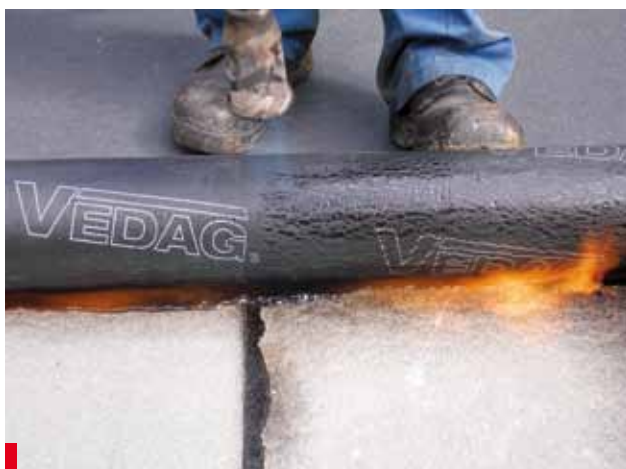
Fot. 8. Specjaliści nie mają problemu z wykonaniem szczelnej hydroizolacji w systemie pap zgrzewalnych
