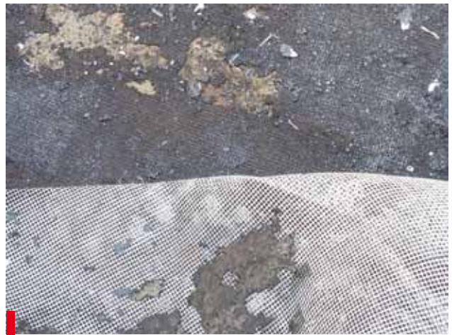
Fot. 4. W przypadku izolacji „produkowanych” bezpośrednio na dachu (branża chemii budowlanej oferuje dużo takich produktów) odpowiedzialność za popełnione błędy najczęściej rozmywa się w dyskusji pomiędzy producentem (dostawcą komponentów) a wykonawcą
