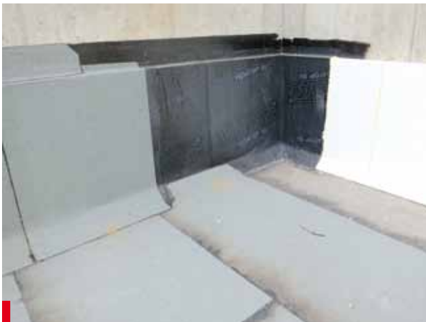
Fot. 13. Bardzo praktycznym uzupełnieniem technologii pap zgrzewalnych mogą być papy samoprzylepne, ale wymagają one od wykonawcy wysokiej sprawności technicznej (na zdjęciu realizacja firmy Termo-Dek)
