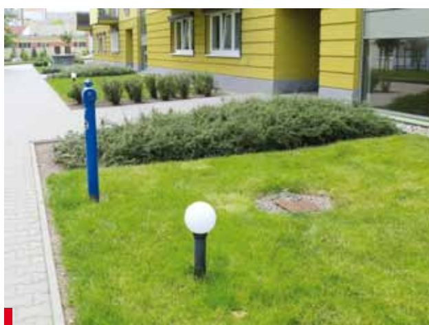
Fot. 22. Po kilku latach próbowano błąd naprawić i nad wpustami pojawiły się studzienki rewizyjne (stan w 2012 roku) umożliwiające kontrolę wpustów...
