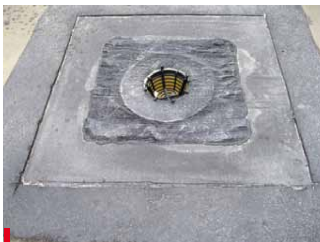
Fot. 20. Osadzenie i uszczelnienie wpustu na dachu użytkowym wymaga starannego przygotowania (realizacja Termo-Dek)
