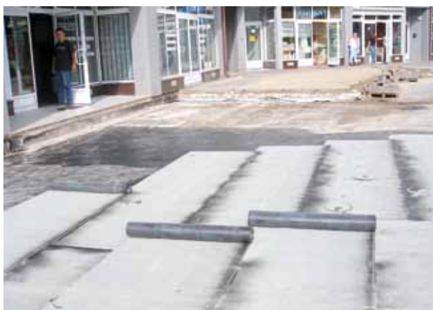
Fot. 10. Prawidłowy układ pap w systemie dwuwarstwowym
