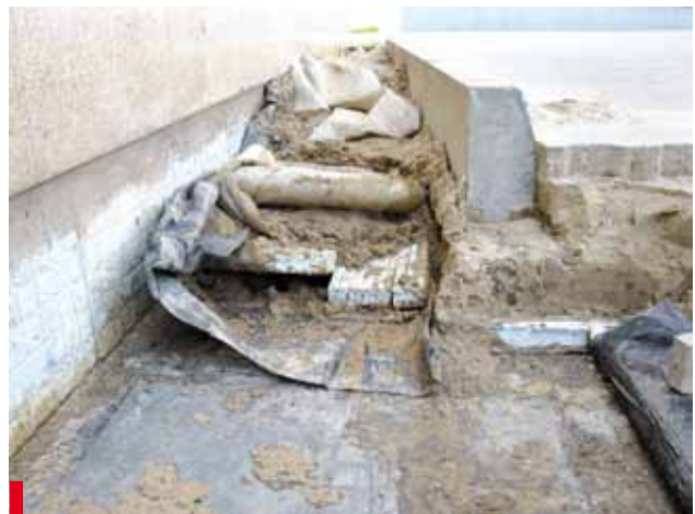
Fot. 24. Drenaż na dachu drogowcom nie jest potrzebny
