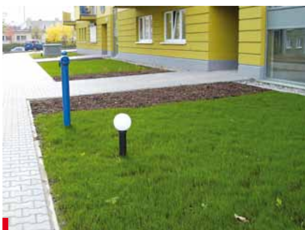
Fot. 21. Na tym dachu zielonym postanowiono zaoszczędzić na elementach nadbudowy wpustów odwadniających (stan w 2007 roku)
